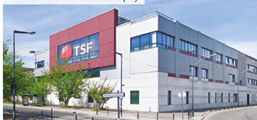
9 rue des Fillettes – Saint-Denis (93)
