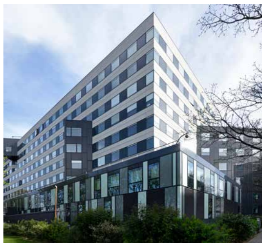
10-12 avenue Charles de Gaulle – 94200 Charenton-Le-Pont
