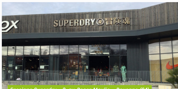
Enseigne Superdry - 2, av. Roger Maylié - Bayonne (64)
